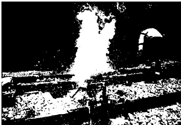
Рис. 5.8. Металлотермитная сварка рельсов
